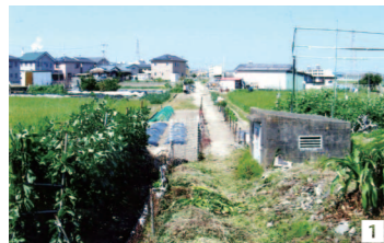
1 面河ダムの水が東へ(埋設管) この辺に国近川の水路があった 2 耕地整理記念碑 国近川はまっすぐ塩屋海岸へ、多くの良田が整備された
