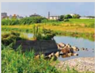
今でもコンクリートで「鎌出し」をつくり、堤防を守っている（徳丸付近）
