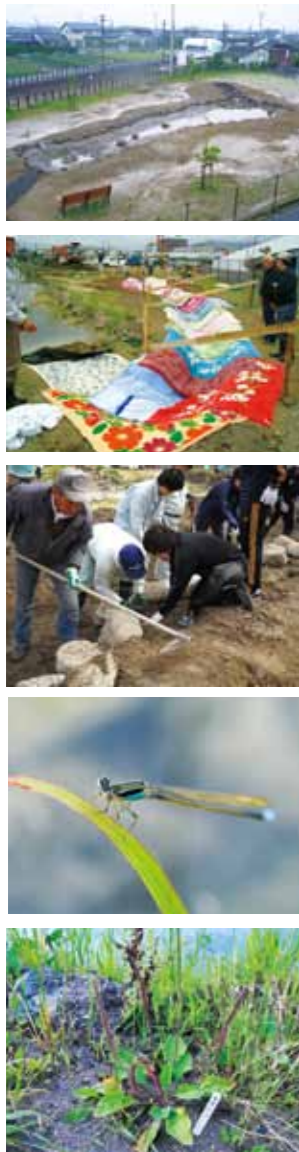
1_敷地中央に約90㎡の池を整備。まず、掘削し真砂土を覆い石組。田の土を入れ、水を入れた 2_池の西にある排水口から約50m東方向に流れをつくり小川を整備。緩衝材として毛布を敷いて防水シートをはった 3_田の土を入れて石組。大勢の力で急ピッチに作業が進む 4_イトトンボ 5_オオバコ
