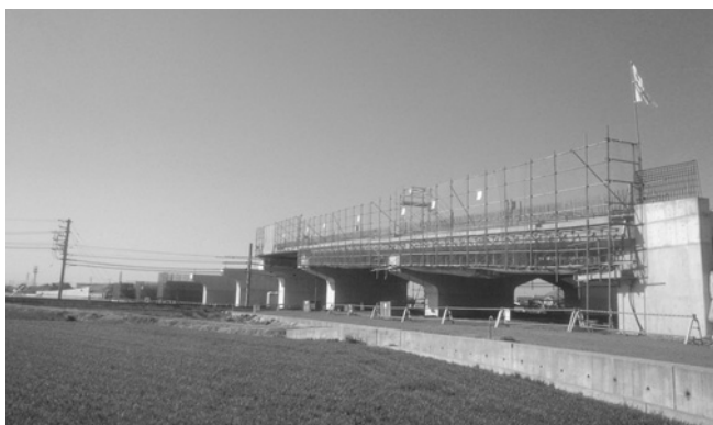
現在建設中の町道筒井徳丸線
