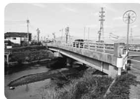
▲（写真3）国近川橋 昭和47年3月完成。旧国道56号。
