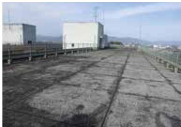
シート防水で、雨漏り解消に
