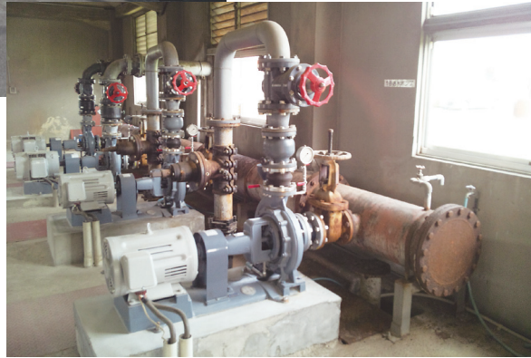
施設への送水管は早急に耐震化を図る
