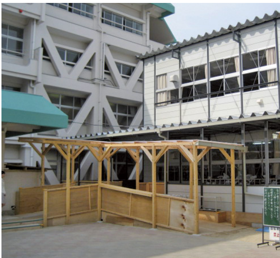
松小耐震改修工事 (プレハブ仮設校舎と併設で)
