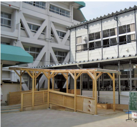
松小耐震改修工事 (プレハブ仮設校舎と併設で)
