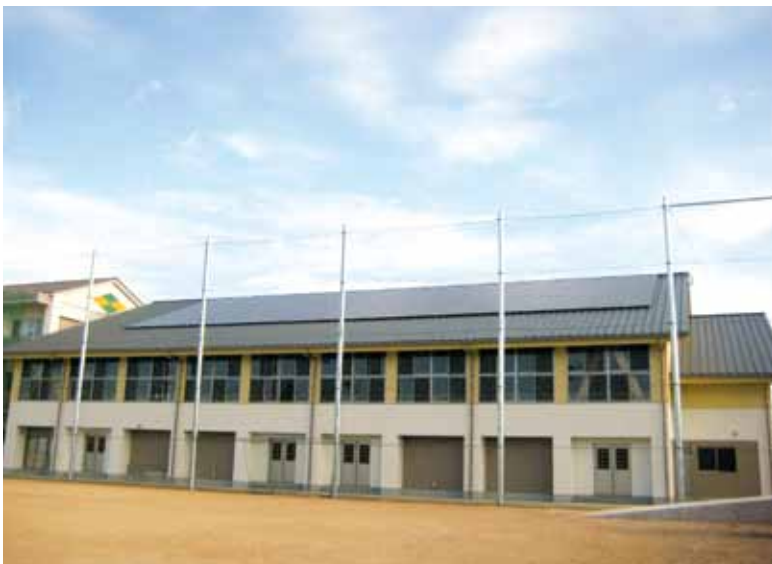
屋根から節電 太陽光パネル (松前中学校体育館)
