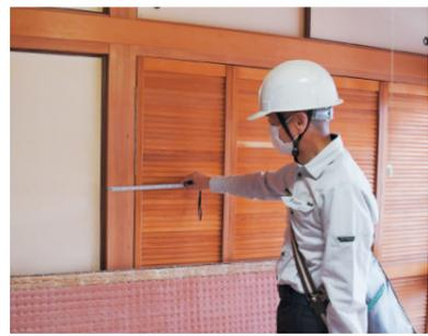
室内では、まず間取りを確認します。その後、柱や壁の厚さを測ったり、雨漏りや床鳴りの有無を調査したりしながら、結果を撮影・記録していきます。
