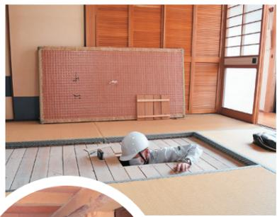
最後に、床下や小屋裏を調査し、住宅の構造、湿気や白アリの有無、基礎部分の劣化状況を確認します。古い住宅は床下が土なので、湿気がひどい場合も。
