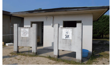
現在の北伊予小学校屋外トイレ
