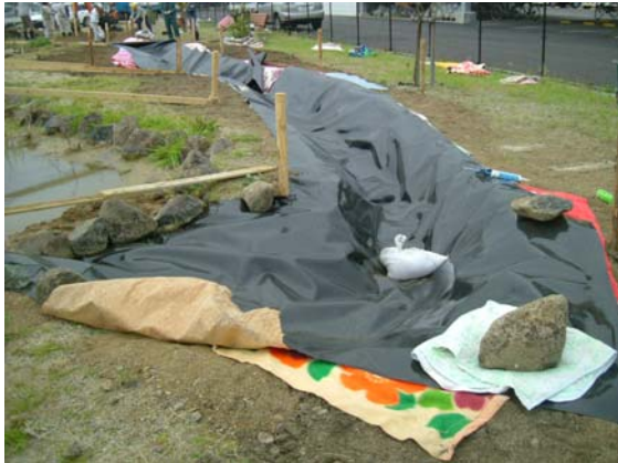
④防水シート張り
