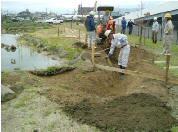
② ユンボで掘削
