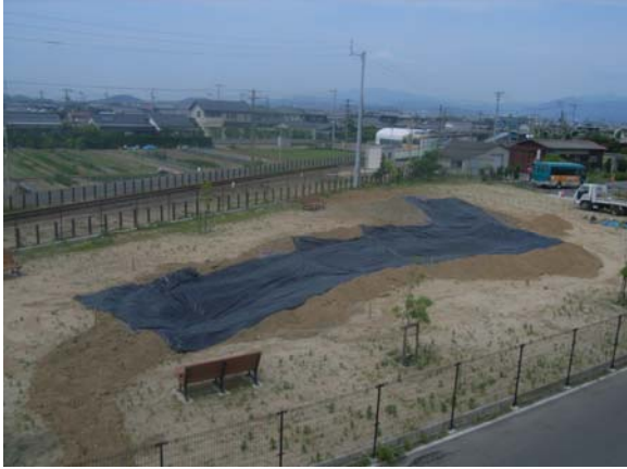
③防水シート張り
