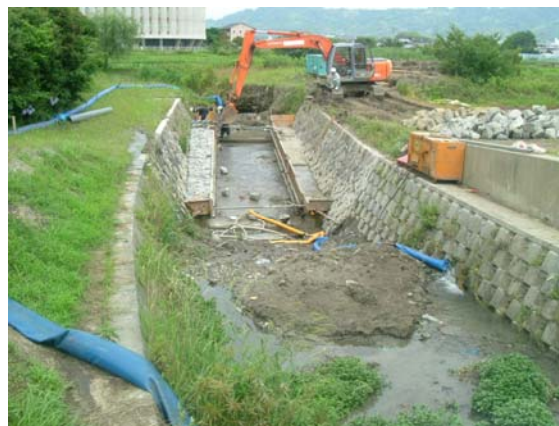
▲工事現場（手前の川底の植物はオランダガラシ）
