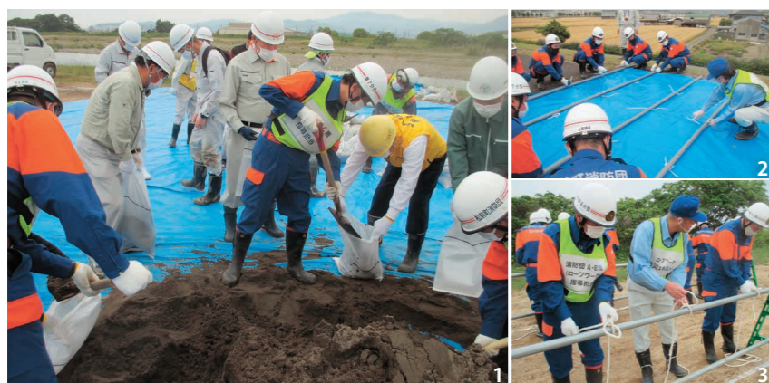
1 協力して土のうを作る参加者 2 川側斜面を保護するシート張り工法 3 水防の基本となるロープワークを学ぶ
