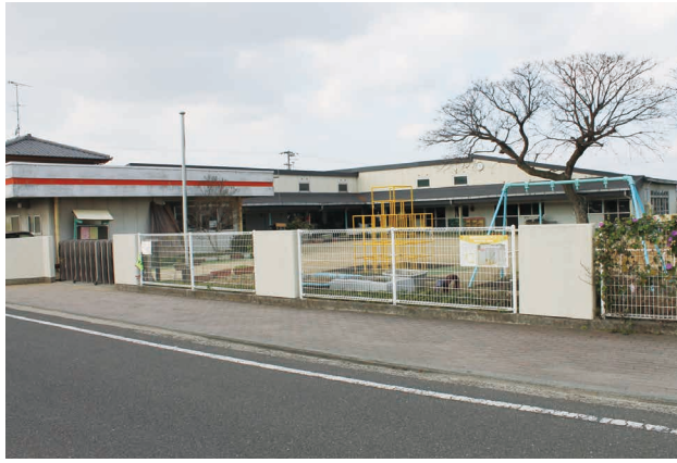
令和5年7月供用開始に変更された白鶴保育所改築
