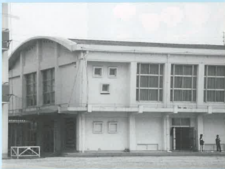
松前中体育館・松前小南校舎 耐震2次診断
