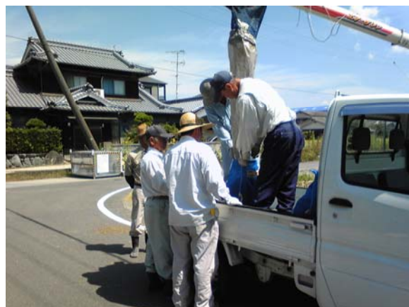
中川原地区作業風景
