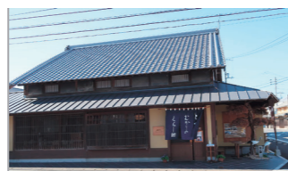
1 砥部むかしのくらし館 梅野精陶所の販売部「旧梅野商会」を改築して造られた展示館。道路拡張のため、曳家という古来の工法で昔の姿のまま移動させた貴重な建物。国の登録有形文化財に指定された
