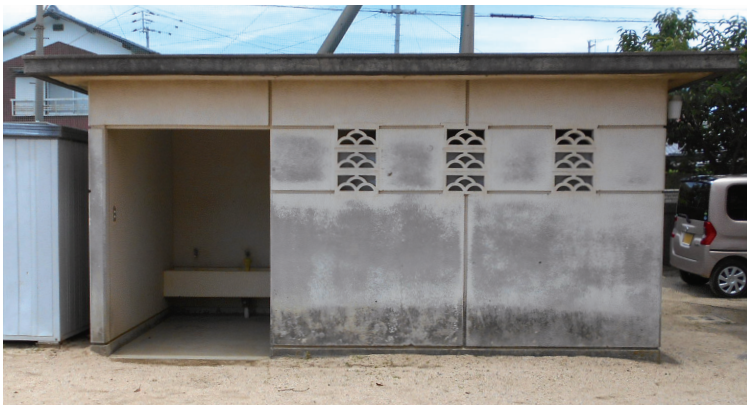
改修が望まれていた松前小学校屋外トイレ
