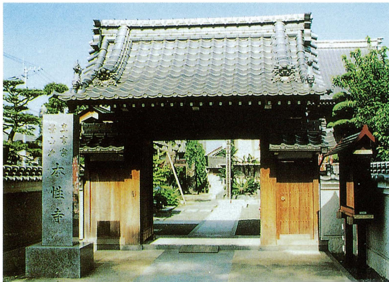
改築された山門
