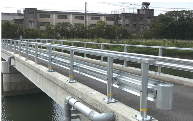
町道認定を受けた塩屋橋
