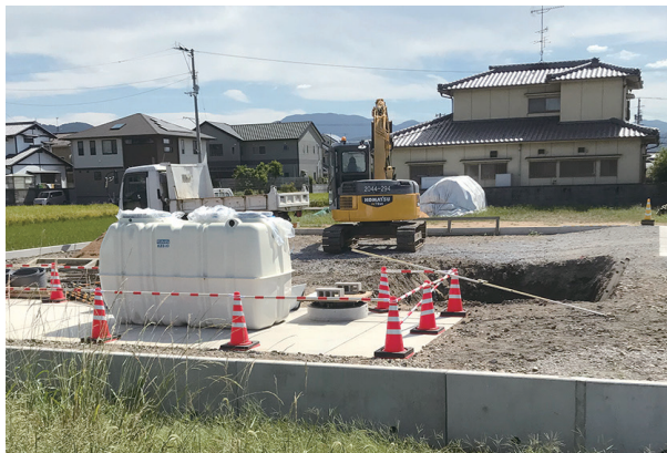
第8分団消防詰所
