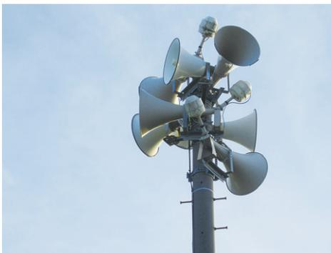
難聴対策工事として町内3か所の屋外拡声子局を高出力の放送設備に取替えなど。
