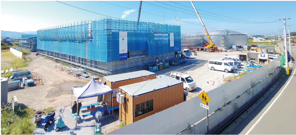
建設中の浄水施設
