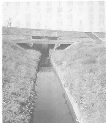
横井手用水樋門（昭和28年竣工）
