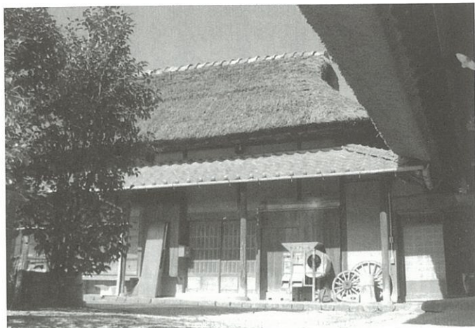
かやぶき屋根の母屋 (東温市にて)
