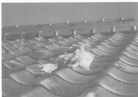
屋根に上げられたしめかざり
