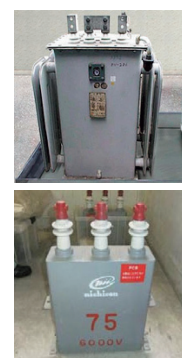
①高圧トランスの例 ②高圧コンデンサの例
