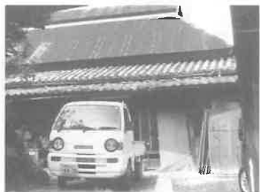
茅葺屋根をトタンで覆った屋根
