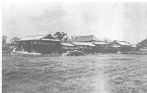
家屋敷全景（昭和45年頃）
