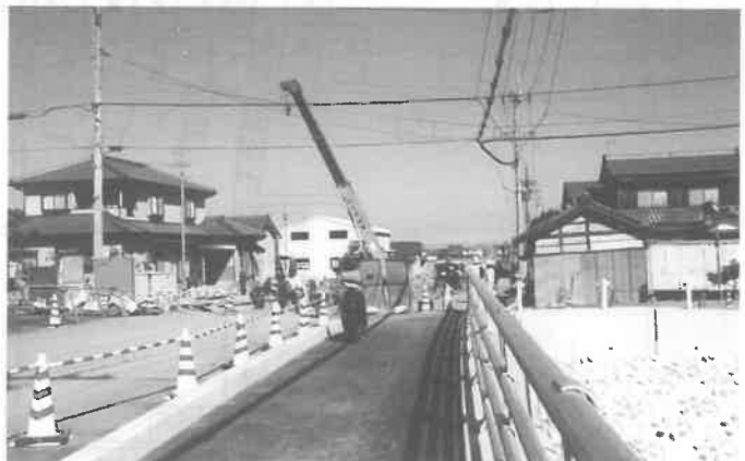
大谷川 横田橋の工事(平成10年)
