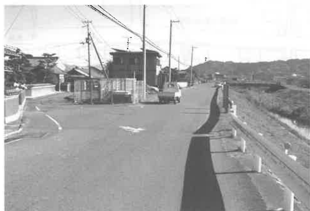
改修後の土手と旧道(左)(平成11年)
