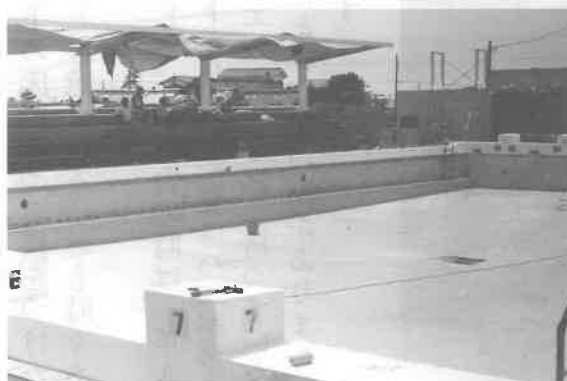
写真29 完成間近い中学校のプール(昭和58年)
