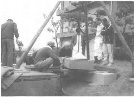
写真26 校名碑の工事(昭和55年)
