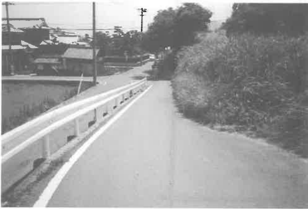
改修前の横田橋北側橋詰め(平成7年)
