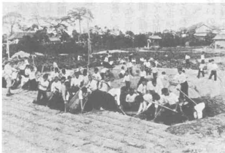
写真14 山王原の開墾作業(昭和10年)
