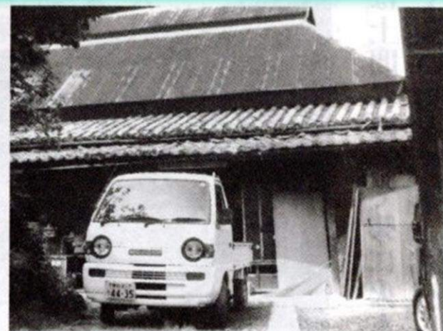
茅葺屋根をトタンで覆った屋根
