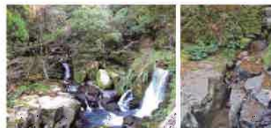
③関吉の疎水溝 (鹿児島市)
