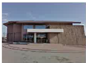
⑤鹿屋航空基地史料館 (鹿屋市)
