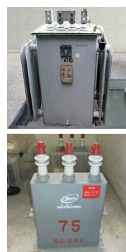
④高圧トランスの例 ⑤高圧コンデンサの例
