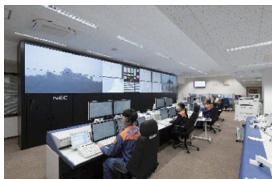
松山圏域消防指令センター
