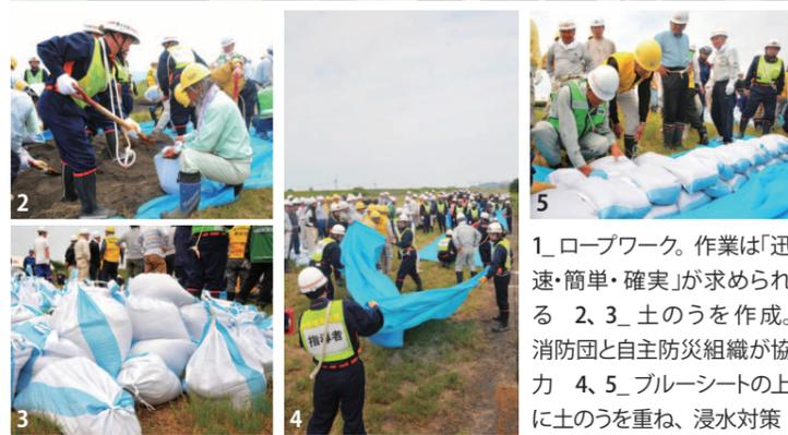
1\_ロープワーク。作業は「迅速・簡単・確実」が求められる 2、3\_土のうを作成。消防団と自主防災組織が協力 4、5\_ブルーシートの上に土のうを重ね、浸水対策
