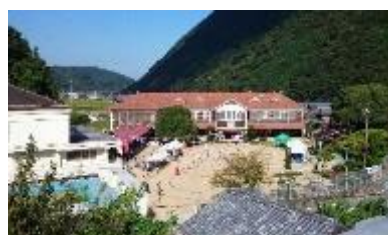
翠小学校の木造校舎
