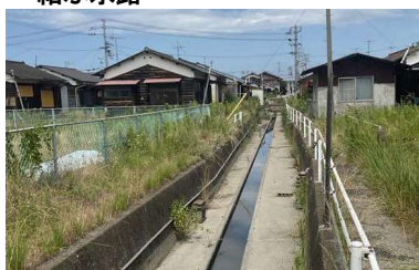
②町道西 75 号線と町道 81 号線を結ぶ水路
