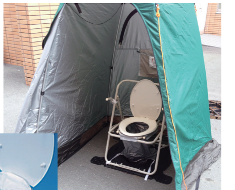
▲マンホール直結式トイレ
