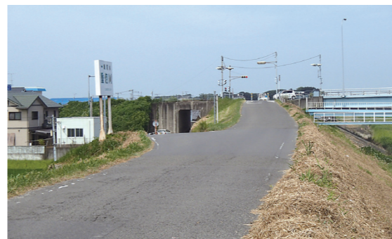
通行止めとなる道路
