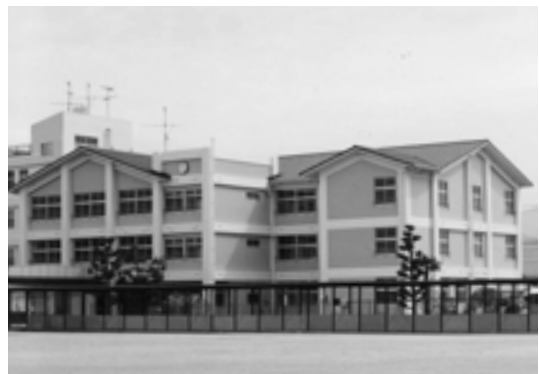
▲岡田中学校管理棟
