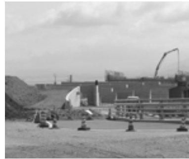
▲工事中の町道筒井徳丸線
