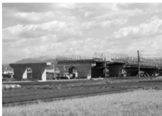
工事中の町道筒井徳丸線
