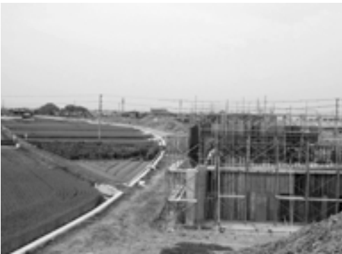
▲工事中の町道筒井徳丸線
