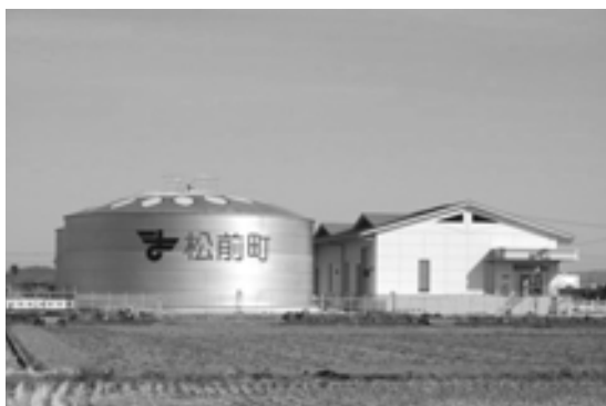
完成した恵久美水源地・浄水場
