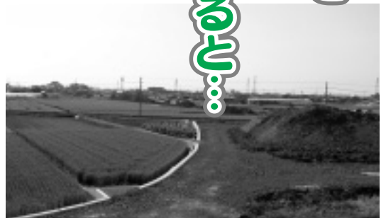
▲建設が進んでいる筒井徳丸線
