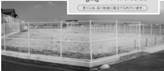
▲完成した出作コミュニティ広場
