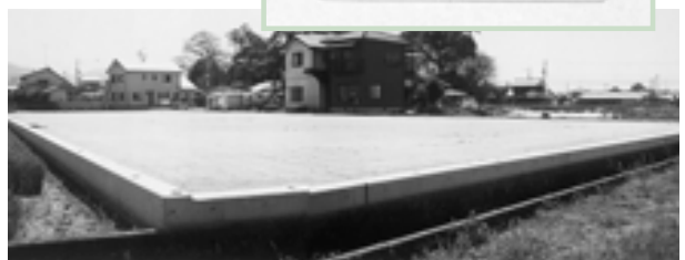
▲造成工事完了後の出作コミュニティ広場
