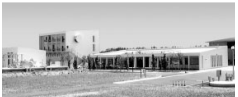
▲松前浄化センター
