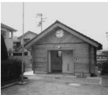
▲地蔵町公園の改築トイレ
