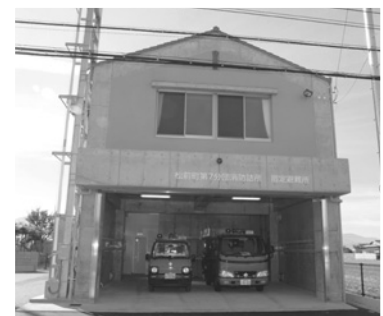
▲消防車庫正面
